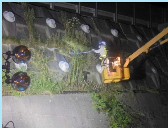
維持作業(除草)
