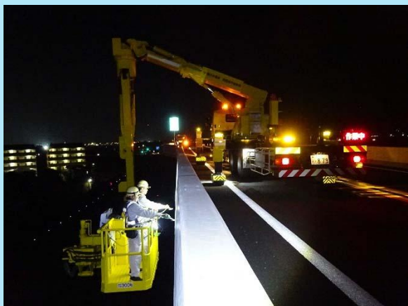
点検作業(橋梁)
