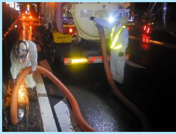
維持作業(排水管清掃)
