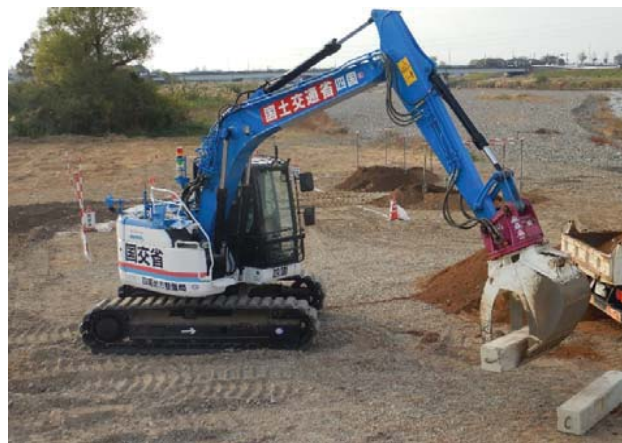
アタッチメントの遠隔操作
