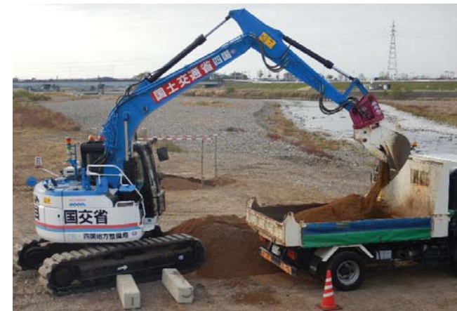
ダンプトラックへの積み込み
