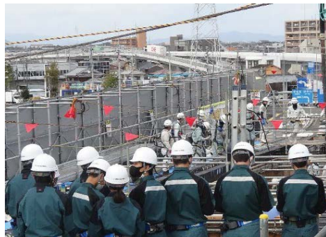
鉄筋組立状況の見学
