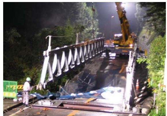
両側トラス架設
