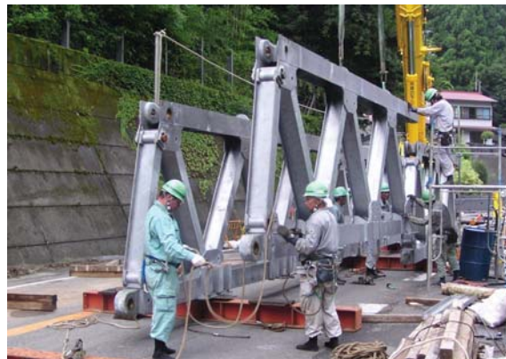
トラス組み立て
