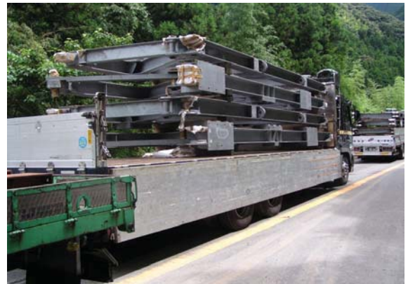
応急組立橋部材搬入
