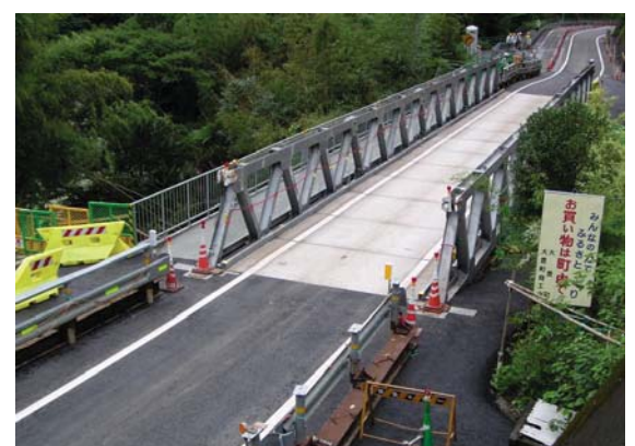
スロープ&外側線施工後通行開始
