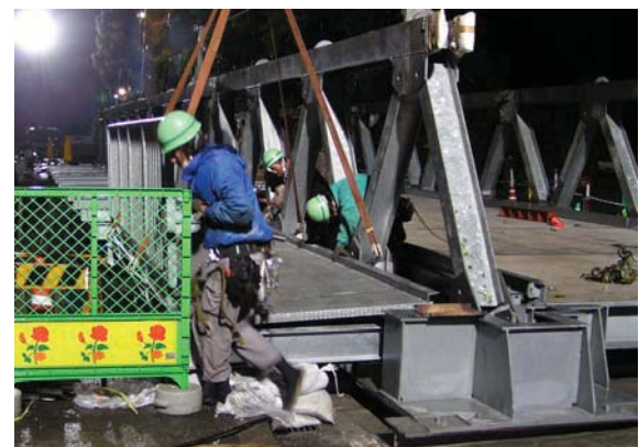
歩道パネル設置
