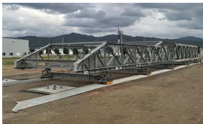
引き出し用の仮トラスが取り付けられた応急組立橋
