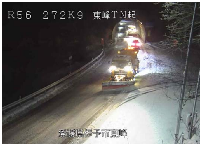
除雪車による除雪作業
