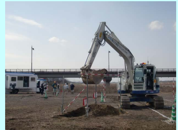
コース走行・掘削の様子
