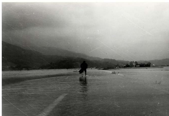
国道56号の冠水状況(松ヶ花方面を望む)
