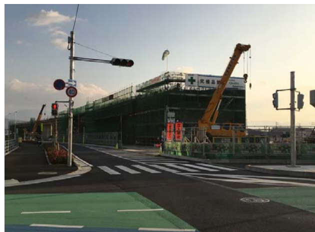
松山外環空港線(余戸西付近)
