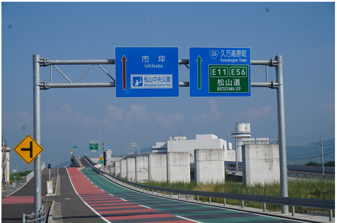
整備箇所：国道 33 号（愛媛県松山市）
