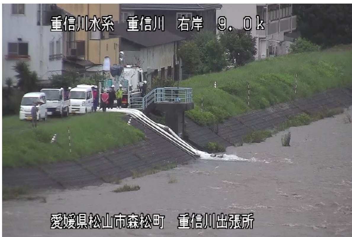
写真 内水排除を行う国交省排水ポンプ車
