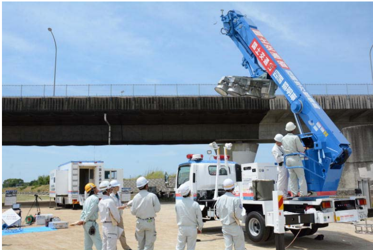
【照明車】 設営訓練状況
