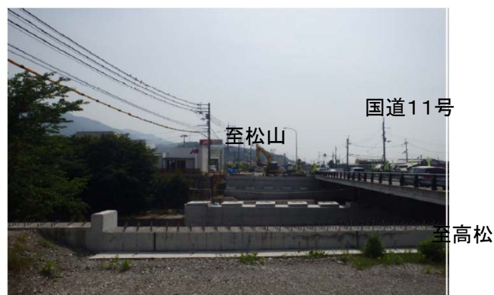
渦井川橋(高松側より撮影)
