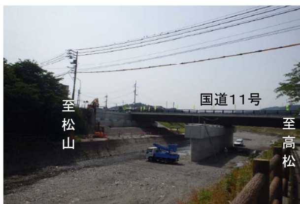
渦井川橋(渦井川上流右岸側より撮影)
