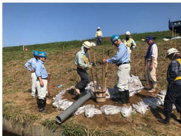
応急復旧状況（月輪工法作業状況）
