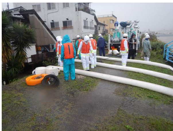
内水排除を行う国交省排水ポンプ車
