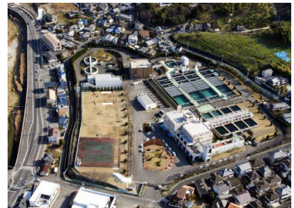
水道資料館「水と人のみらい館」 (市之井手浄水場内)
