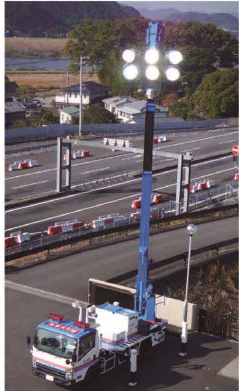
照明車 (2kW×6灯)
