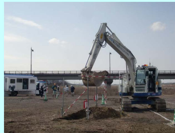
コース走行・掘削の様子
