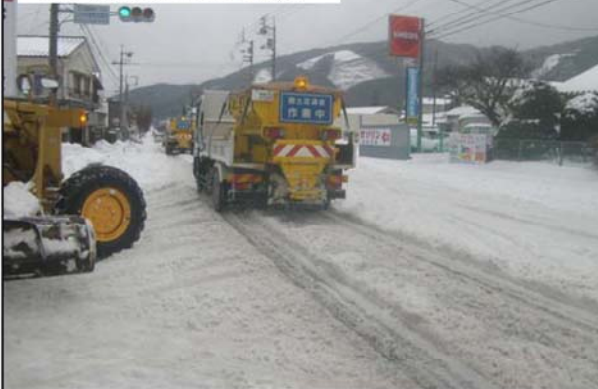
融雪剤散布作業状況
