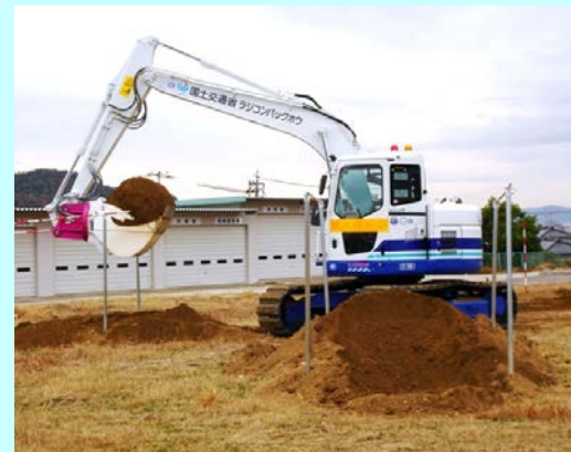
コース走行・掘削の様子
