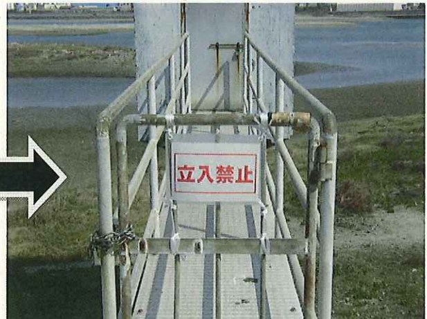
立入禁止看板の設置
