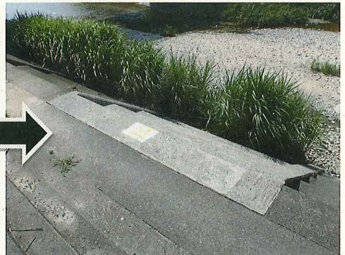
護岸の設置及び注意喚起の表示
