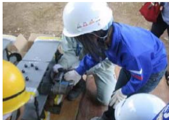
【高力ボルトの締め付け体験】
