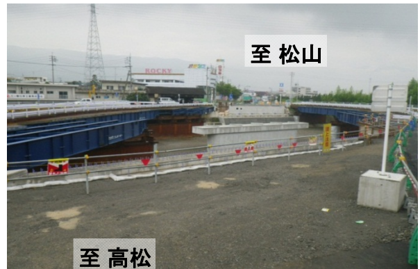
仮橋と仮橋の間に下部工(橋台2基、橋脚1基)を施工
