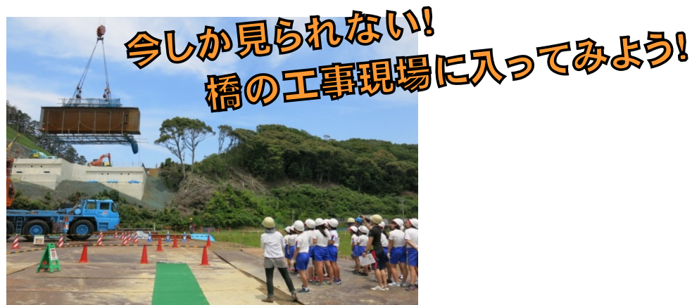
【鋼桁の架設見学】
