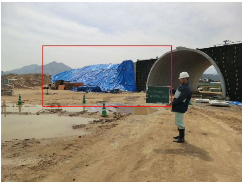
写真-2 No. 70+80付近 搬出土盛土全景 (②)
