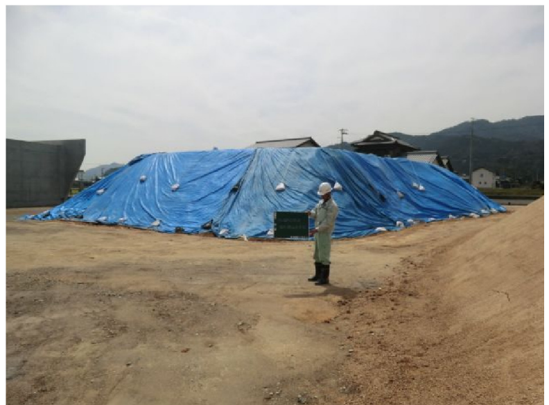
写真-1 No. 62+00付近 搬出土仮置き状況 (①)
