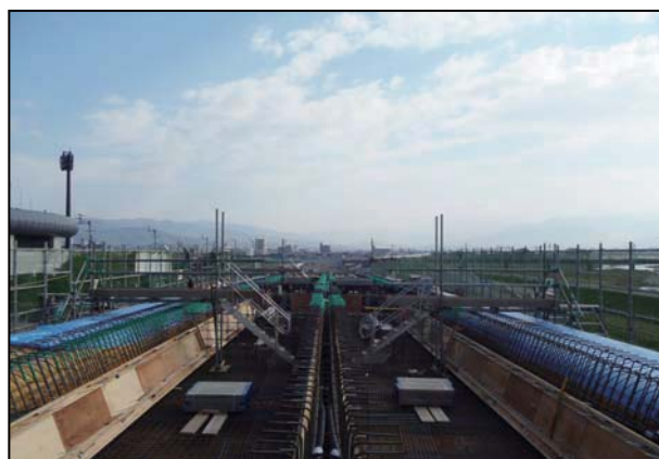
橋桁の施工(橋の上面)
