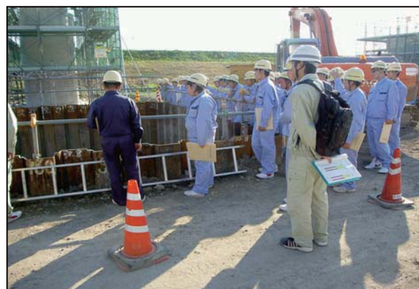
橋脚の仮締切
