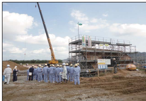
橋脚の鉄筋型枠組立
