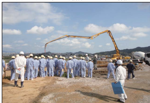
コンクリートポンプ車による橋脚のコンクリート打設
