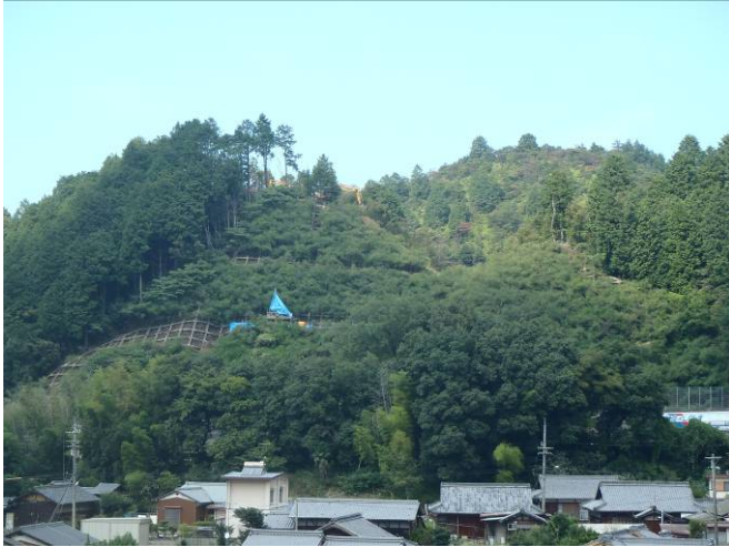
○平成25年9月23日(月) 地山切除状況
