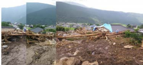
土砂災害被災状況調査
