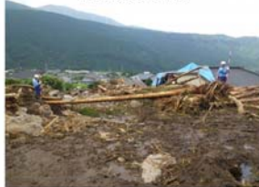
土砂災害被災状況調査
