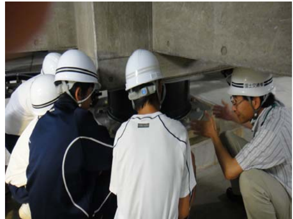
庁舎地下の免震構造の見学
