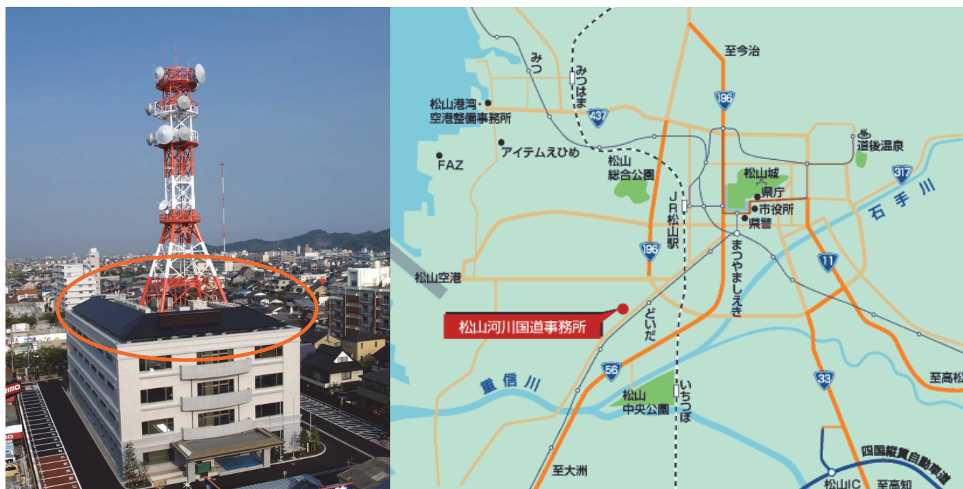
庁舎屋上の太陽光発電
