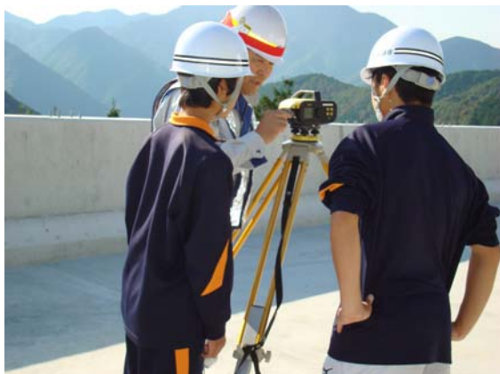
工事中の橋梁上部での測量体験
