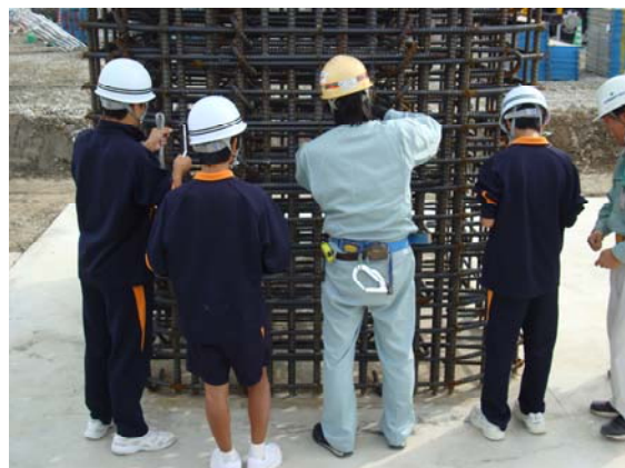
橋梁下部の鉄筋結束体験
