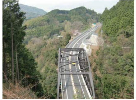
写真② 三坂第2トンネル 松山側坑口
