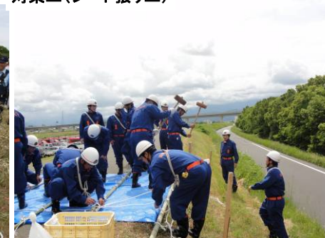
対策工(シート張り工)
