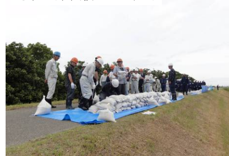
対策工(改良積み土のう工)
