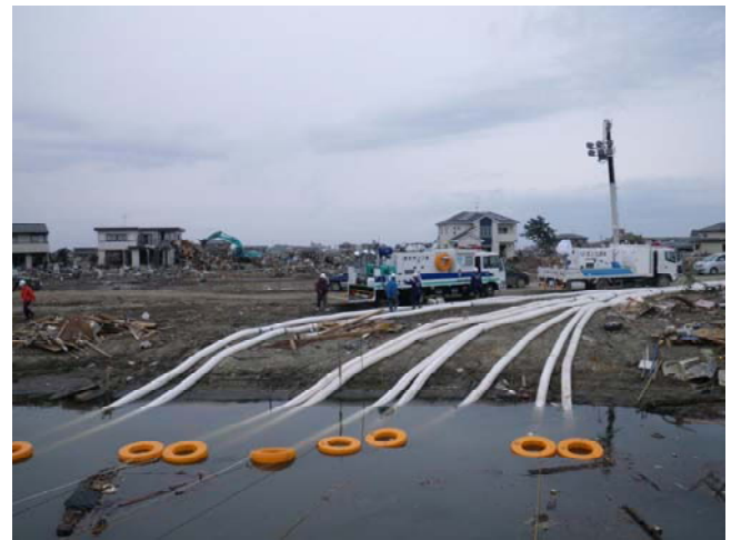
写真-2 東日本大震災排水ポンプ車派遣状況
