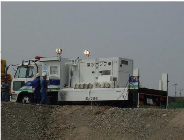
写真-1 排水ポンプ車
