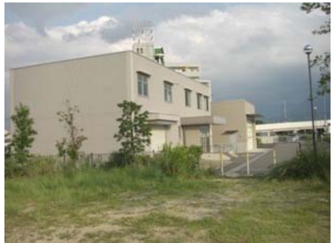
④重信川防災ステーション
