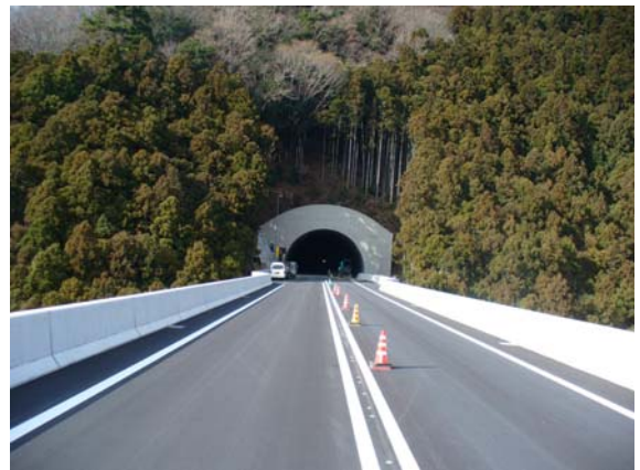
写真② 三坂第2トンネル 高知側坑口(H24.1.26撮影)
