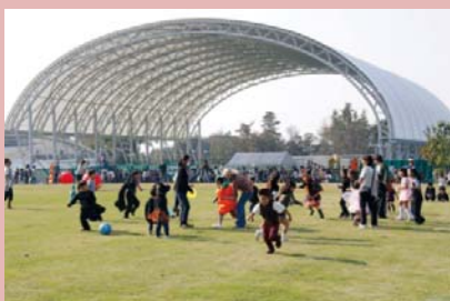
ドラ夢ドーム ：雨天・炎天時等にも利用できる全天候型多目的運動場です。
