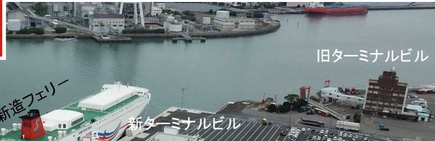
岸壁背後の利用状況
