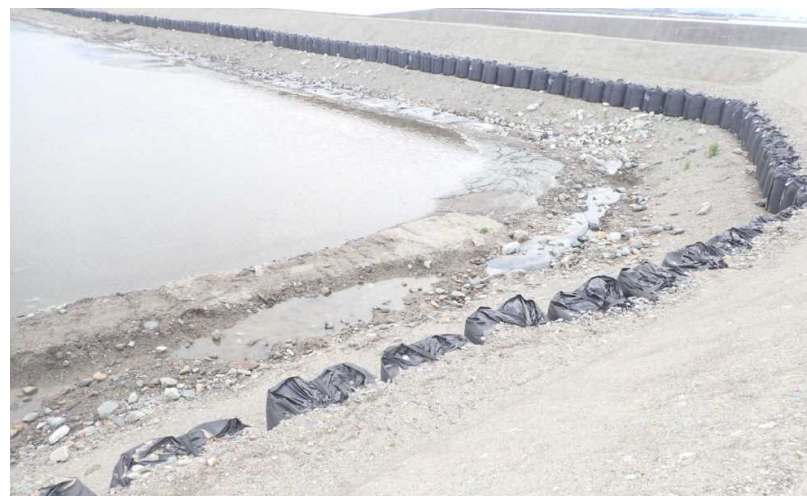
既設護岸への築堤整備状況
