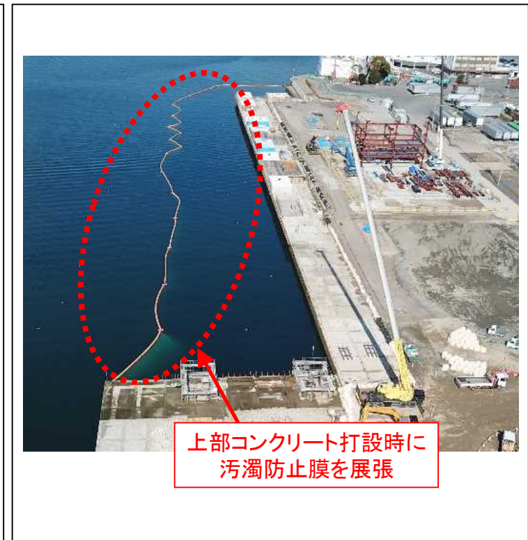
関係者調整(濁り防止対策)
