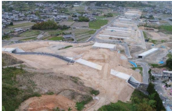
工事進捗状況 (今治IC～今治朝倉IC(仮称))
