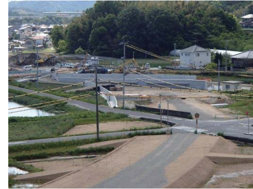
3工区で進む改良工事 (H30. 5)
