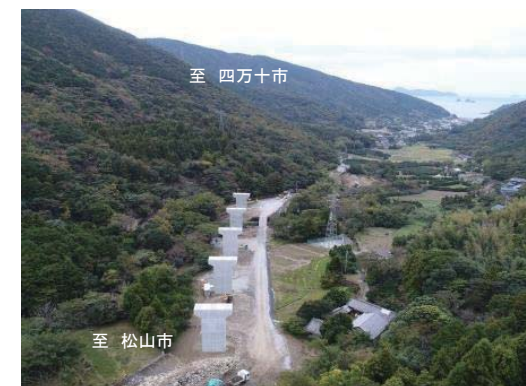
【写真② 内海IC(仮称)付近橋梁工事】
