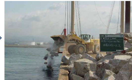
石材の投入状況
