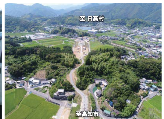
工事進捗状況(鎌田IC～波川)
