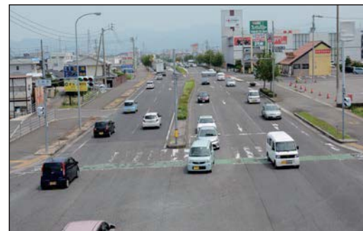
開通区間の状況 (川之江三島バイパス)
