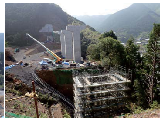
和田高架橋下部工事進捗状況 (平成29年8月上旬)
