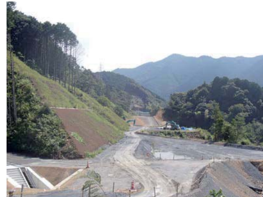
和田地区改良工事進捗状況 (平成29年9月下旬)
