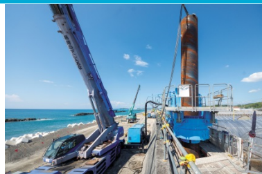
新居工区堤防耐震工事施工状況
