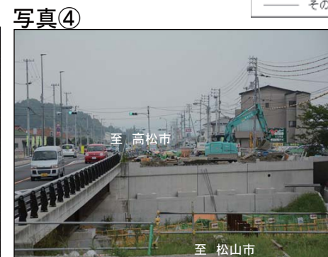
H30開通予定区間進捗状況(拡幅)
