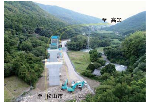
進捗状況 (内海IC(仮称)付近橋梁工事)
