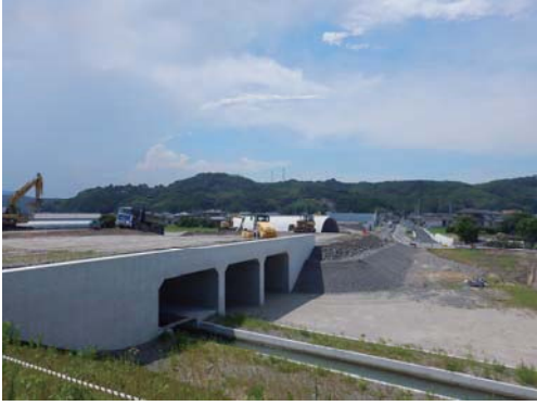
改良工事進捗状況
