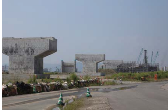
橋梁工事進捗状況
