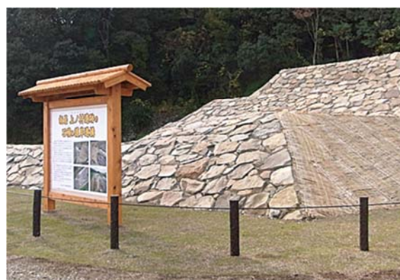
完成した護岸遺構モニュメント
