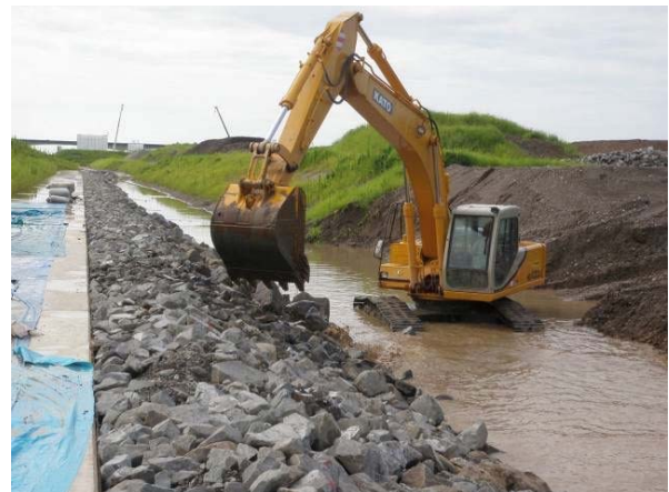
建設発生岩塊の破碎と利用状況
