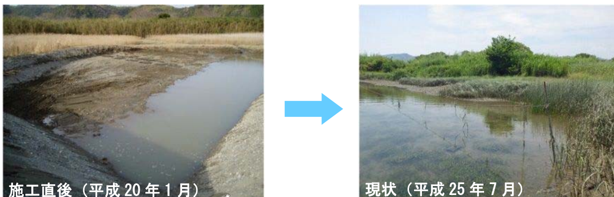
図-6.6 代替環境1の施工直後と現状
