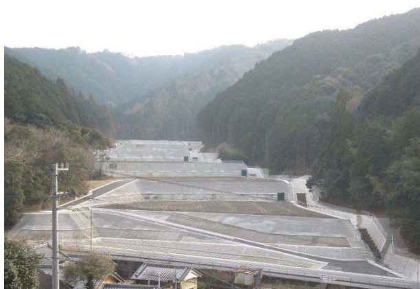
残土を活用した圃場整備状況（平成25年1月）
