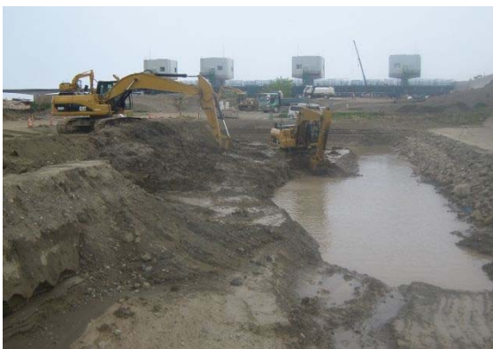
粘性土の発生状況
