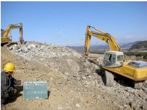
建設発生岩塊の破碎と利用状況
