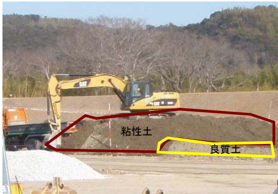
建設発生土（粘性土）を利用した導流堤の盛土状況（新居地区）
