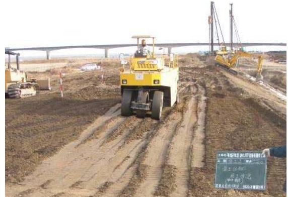
建設発生土（粘性土）を利用した導流堤の盛土状況（新居地区）
