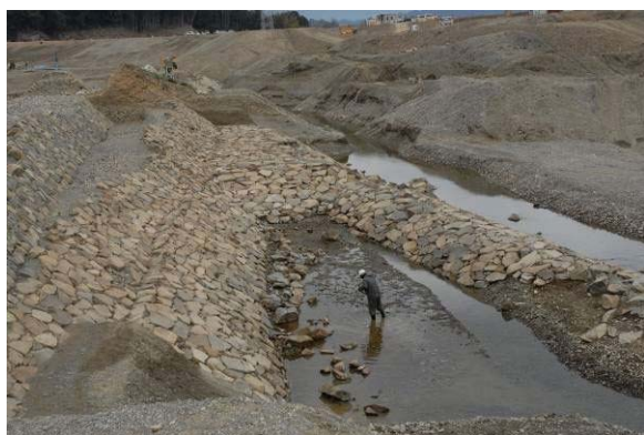
石積み護岸遺構
