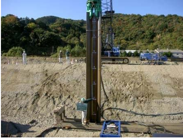
矢板施工状況
