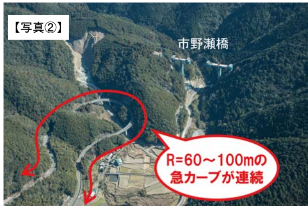
【現道の線形不良区間（ヘアピンカーブ）】
