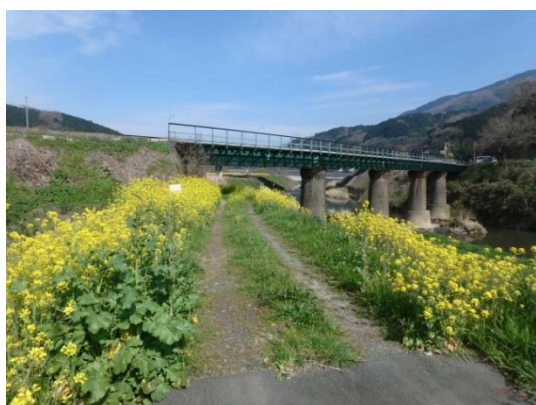
JR 矢落川橋梁
